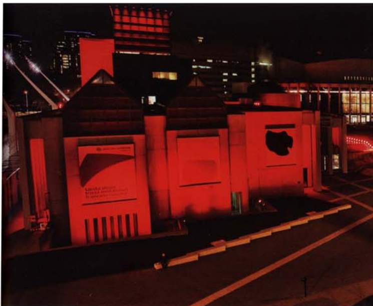
Le concept d'illumination respecte l'architecture des édifices en dissimulant soigneusement les sources de lumière et utilise largement la DEL par souci d'économie d'énergie.
